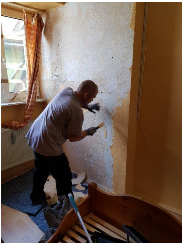
Renovierung der Zimmer des Übergangswohnens
